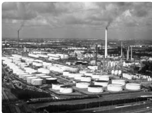
Obr. 1 Rafinérie využívajú veľkoobjemové uskladňovacie nádrže, v ktorých je presné meranie základom
